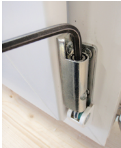
2. Justering höjddled, nedre gångjärn
