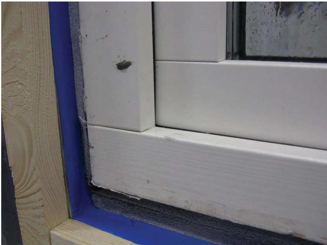
Bild 12: Insida vägg med svällande fogband mellan fönsterkarm och konstruktion.
