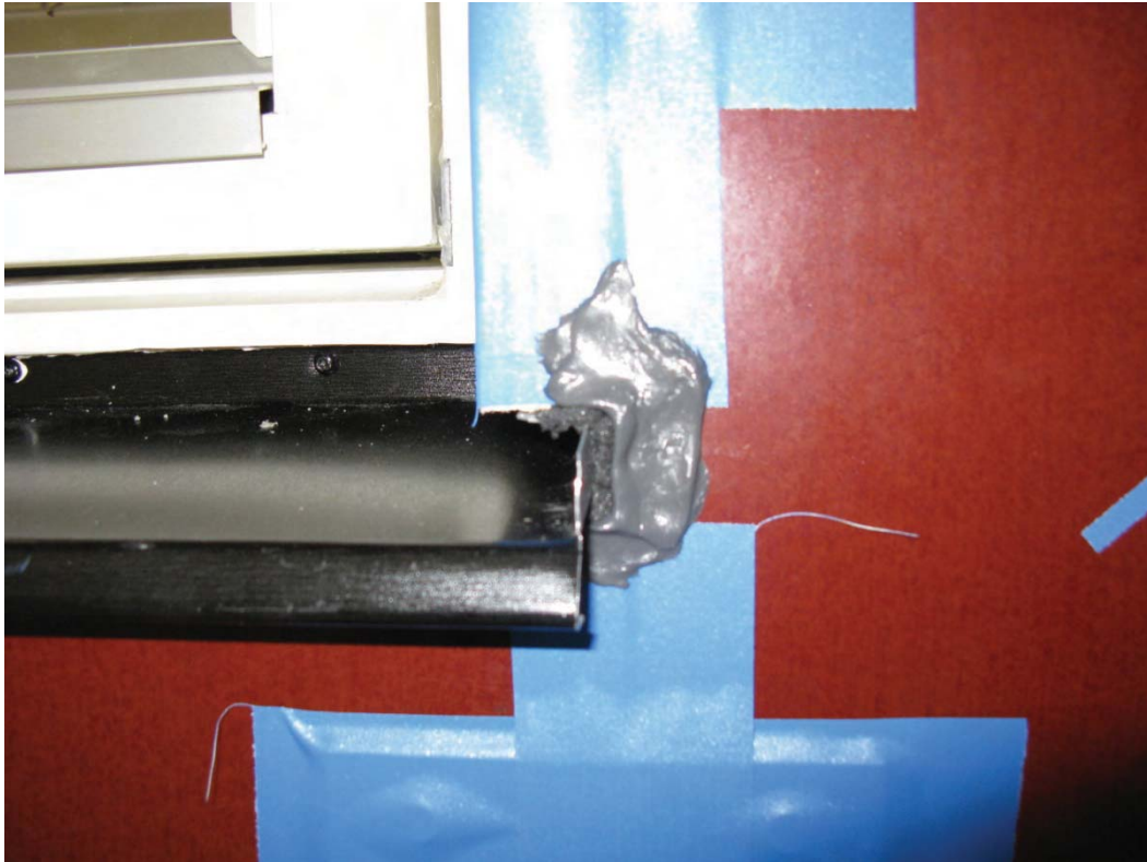
Bild 5: Knådplast som motsvara fog mellan puts och fogband vid sida fönsterbleck
