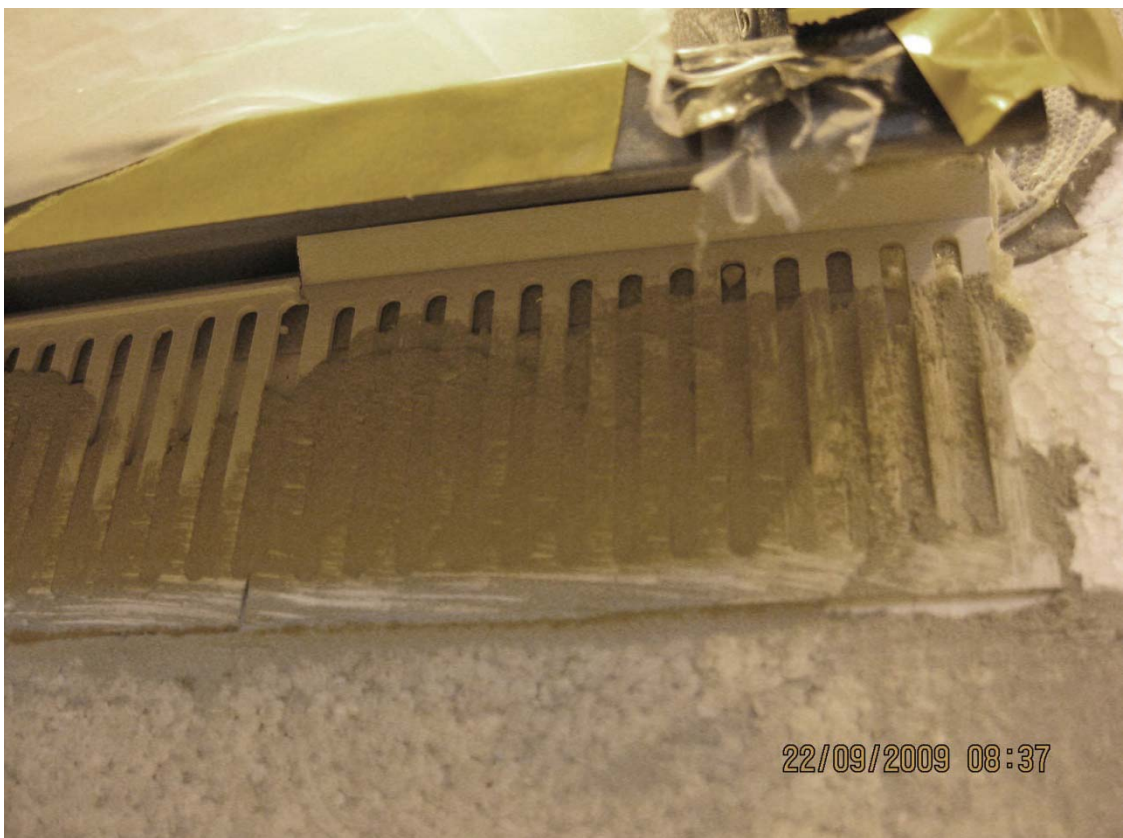
Bild 12: Utsida vägg. Slutligen skapades dränage och tryckutjämningsöppningen med distans av hopplockade detaljer av plast.
