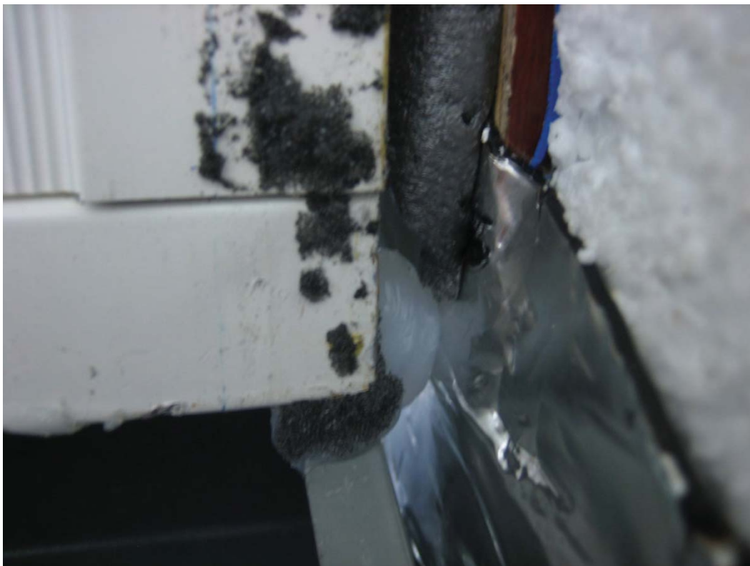
Bild 3: Utsida vägg. Bottningslist monterad.
