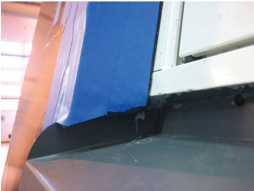
Bild 4: Utsida vägg. Detalj av färdigt montage.
