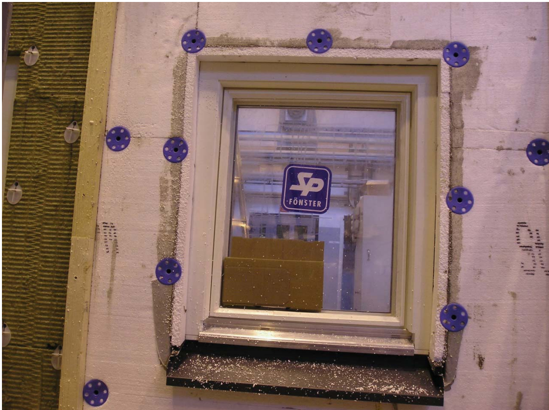
Bild 5: Utsida vägg. Fogband monterat under press av cellplastdetaljer.
