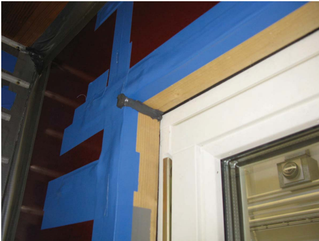
Bild 3: Träreglar mot fogband (med knådplast i hörnet) som motsvara en konstruktion med puts/fogband
