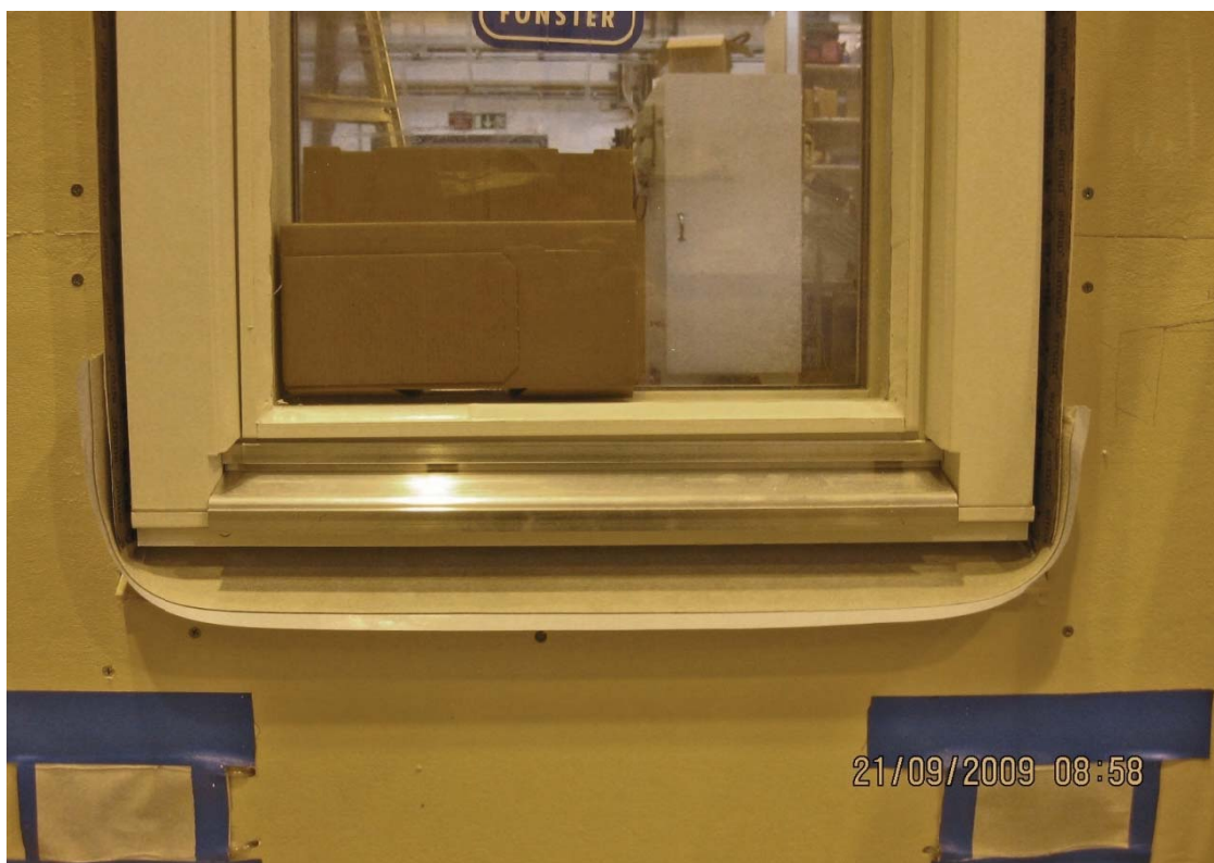
Bild 3: Utsida vägg. Fiberduken går hela vägen ut till utsidan av cellplast samt uppvikt ca 10 cm på vertikal regel och cellplast. Obs! cellplast är inte monterad ännu.
