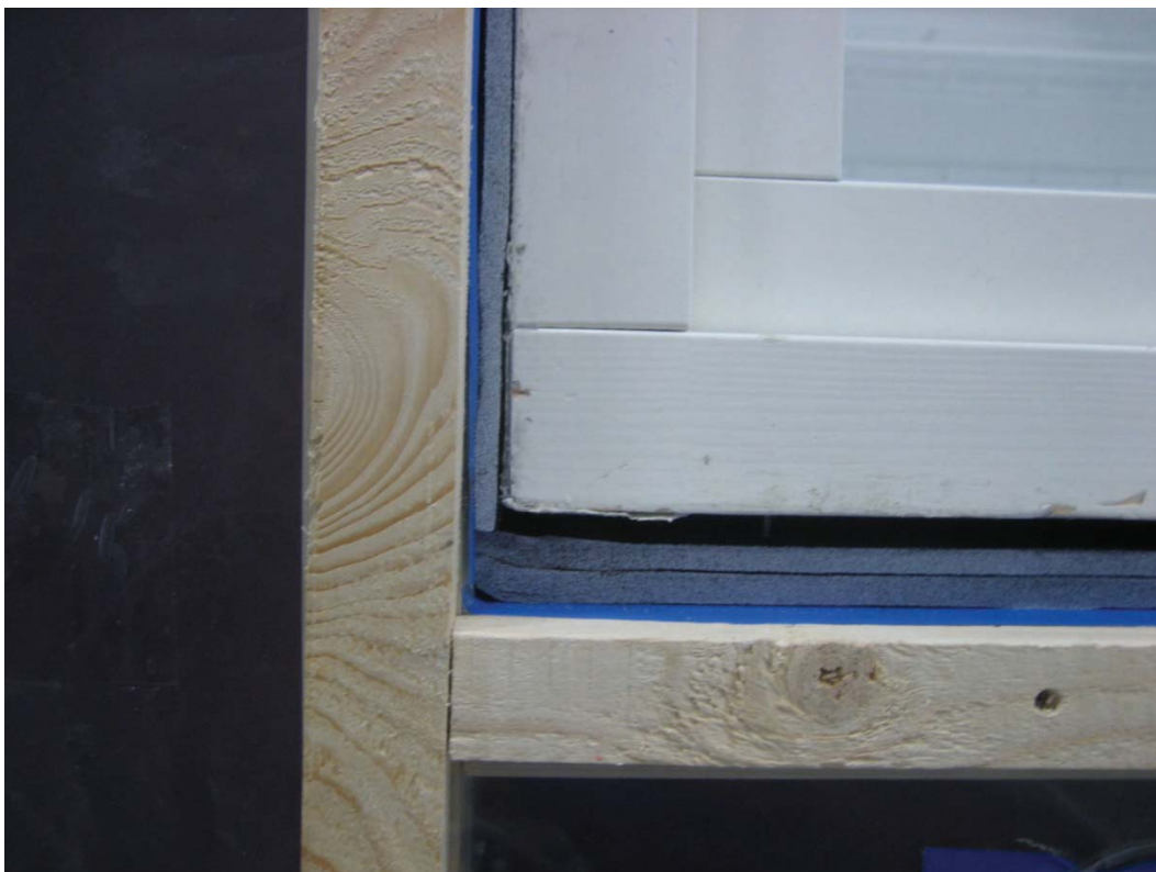
Bild 6: Yttre tätning med svällande fogband.
