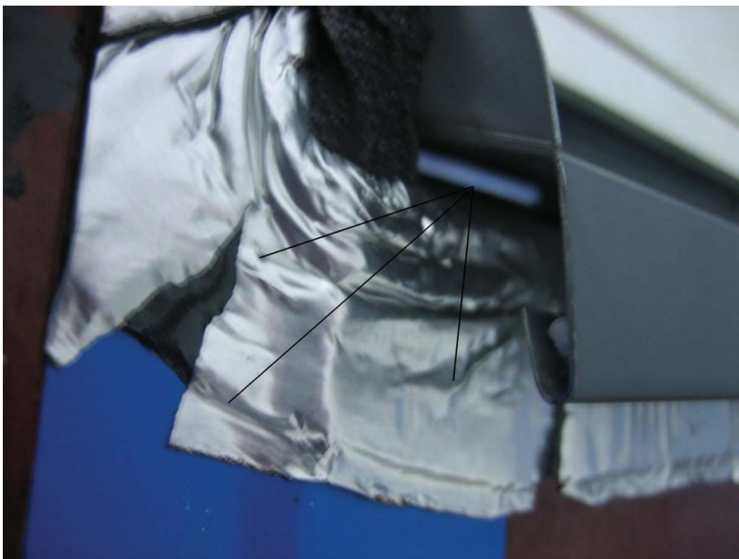
Bild 6: Utsida vägg. Här syns dränage/tryckutjämningsöppningen på ca 8 mm.
