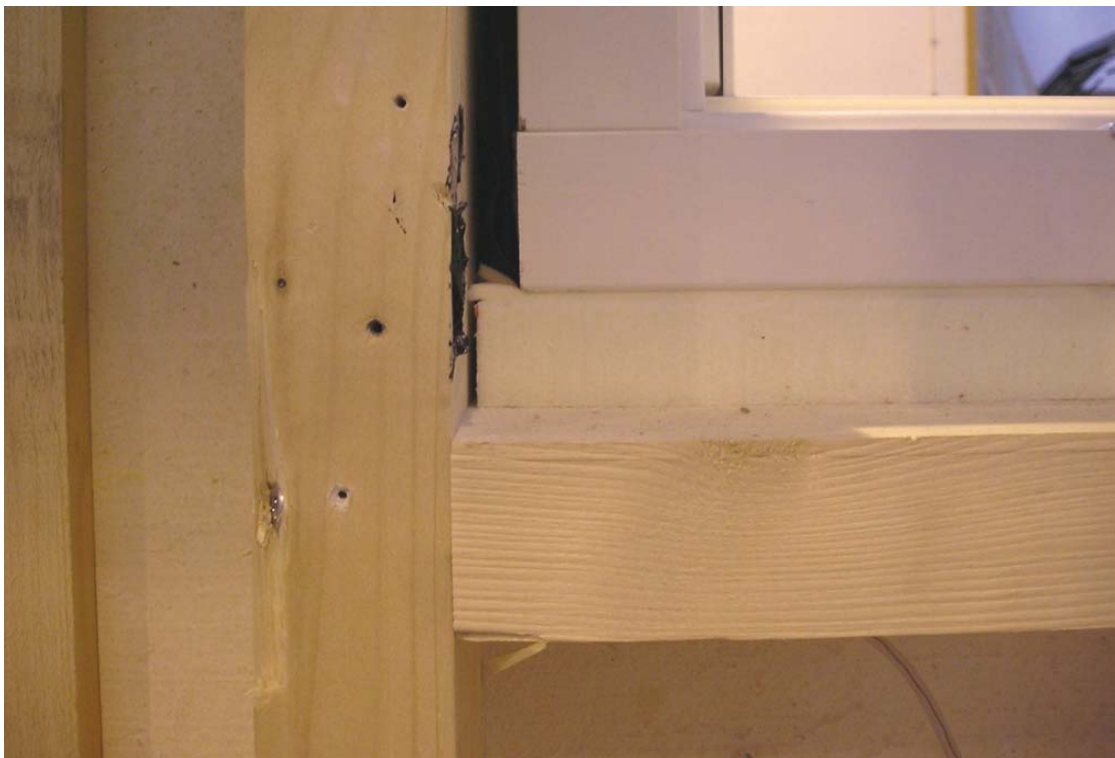
Bild 20: Insida vägg. Fönstret vilar på en kombinerad kil och rektangulärt upplag i ett stycke av polyuretanskum.
