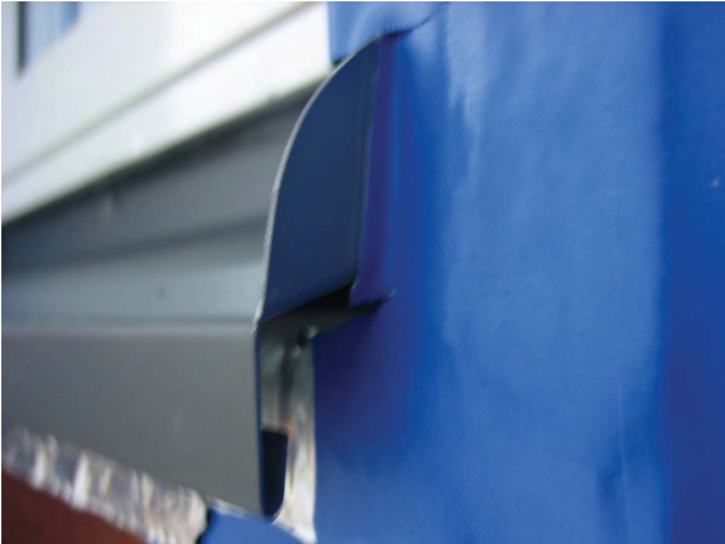
Bild 7: Utsida vägg. Detalj av färdigt montage.
