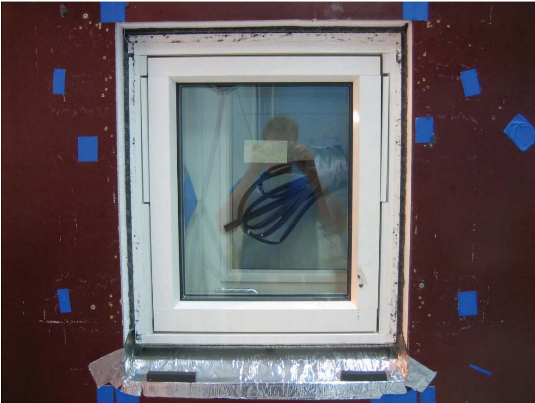
Bild 2: Utsida vägg. Innan puts (blå tejp) applicerades.
