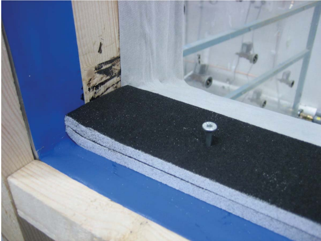
Bild 3: Yttre tätning med svällande fogband.
