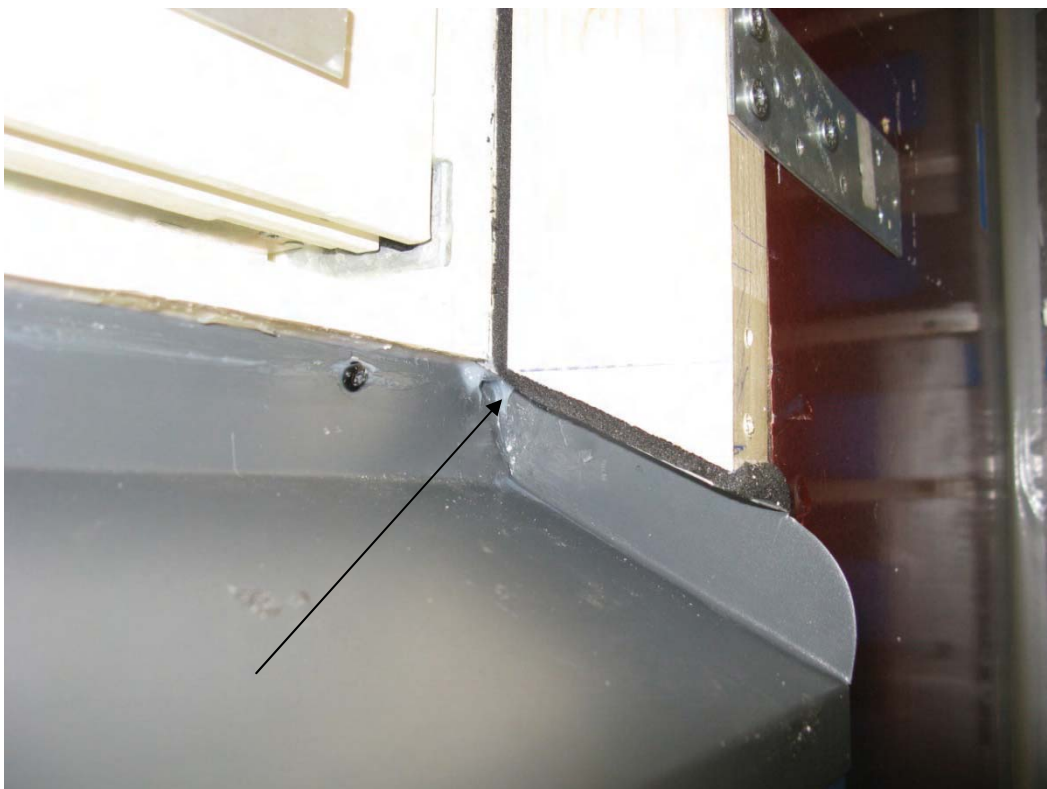
Bild 2: Silikon applicerades i hörnet av fönsterbleck
