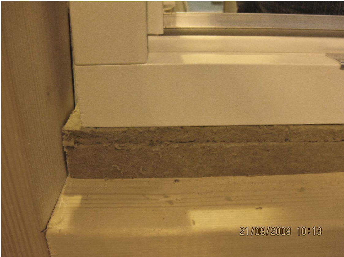
Bild 13: Insida vägg. Fönstret vilar på en kombinerad kil och rektangulärt upplag i ett stycke av stenull.
