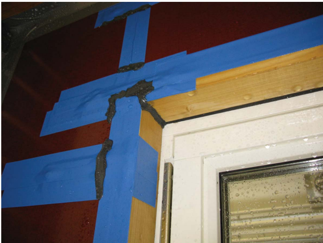
Bild 2: Träreglar mot fogband (med knädplast i hörnet) som motsvarar en konstruktion med puts/fogband
