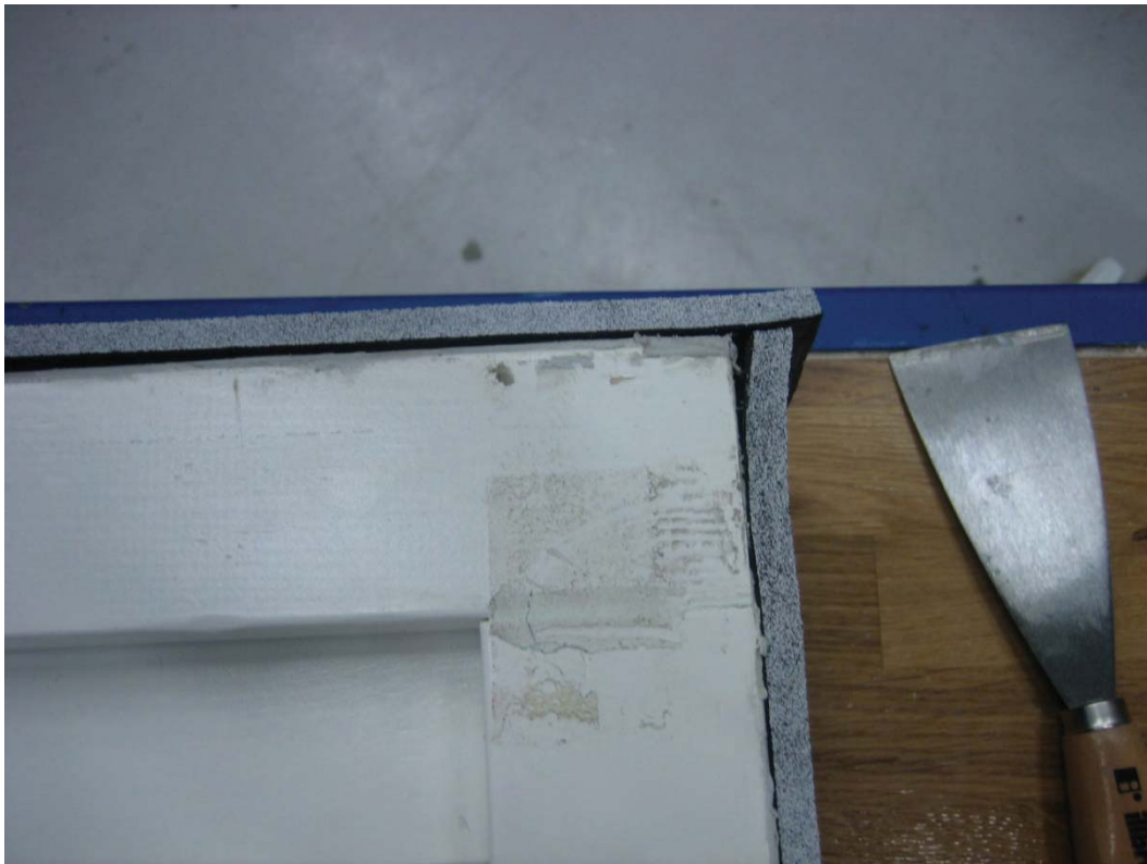
Bild 5: Yttre tätning med svällande fogband.
