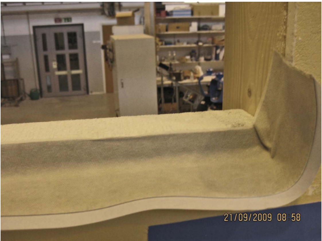
Bild 8: Utsida vägg. Fiberduk klistrad på cellplast med djup som motsvarar ca halva karmens djup.
