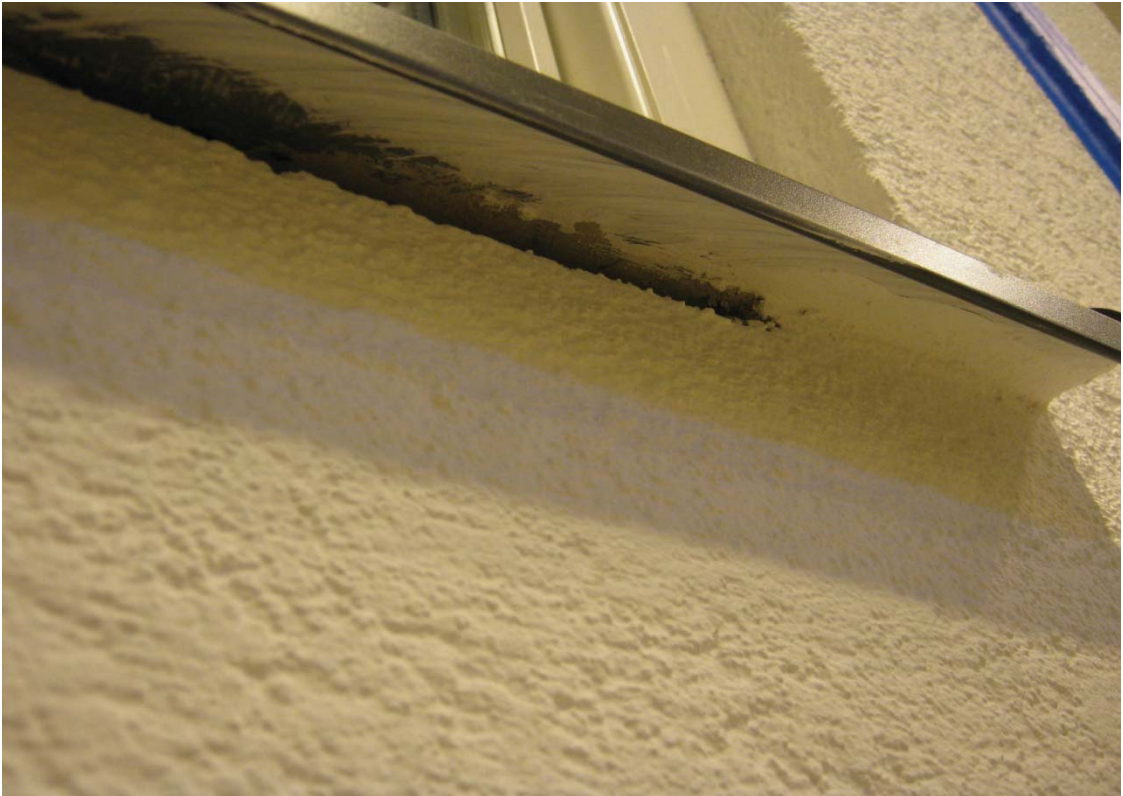
Bild 24: Utsida vägg. Slutligen skapades en dränage och tryckutjämningsöppning under fönsterblecket.
