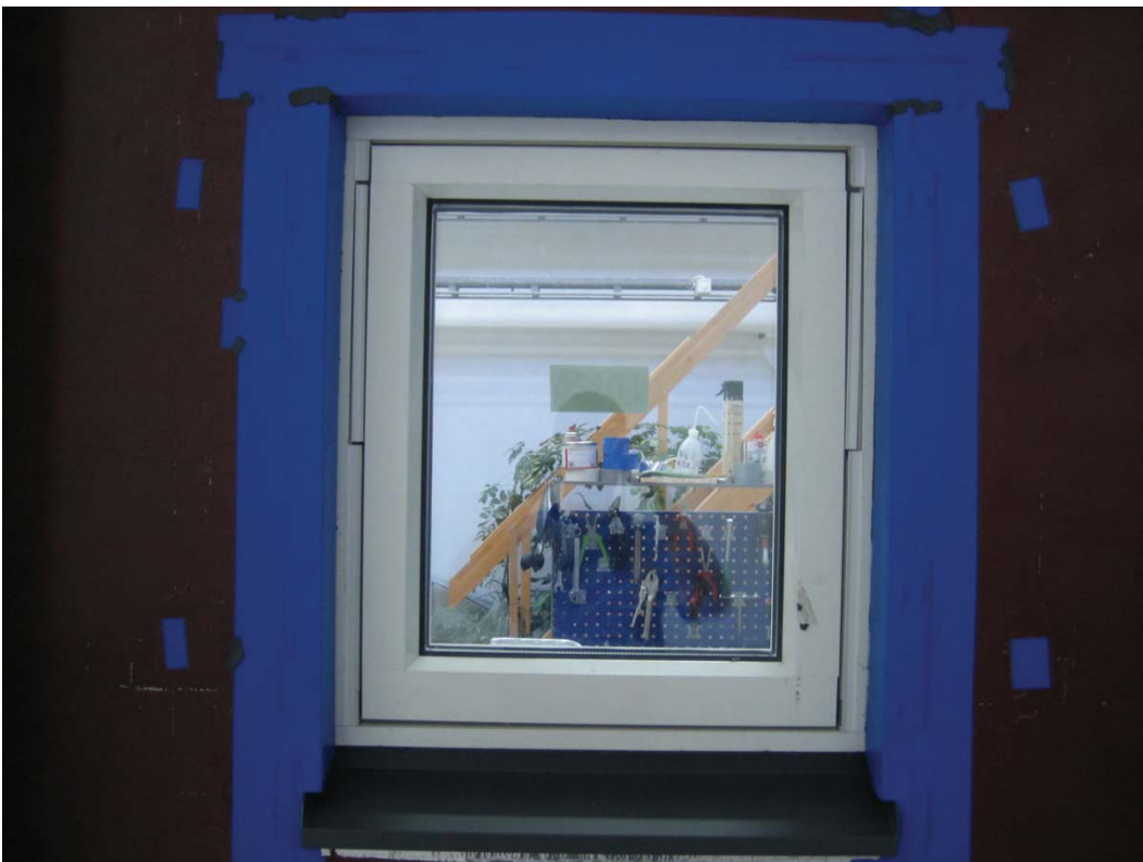
Bild 8: Utsida vägg. Färdigt montage.
