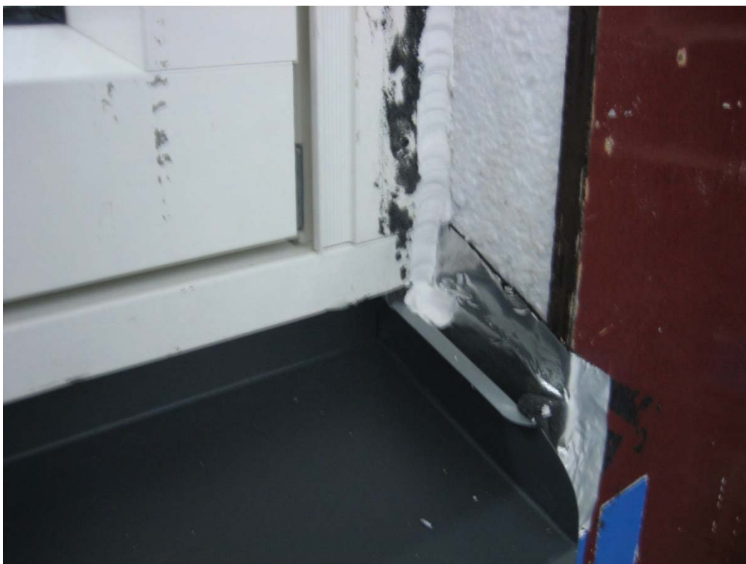
Bild 4: Utsida vägg. Fog applicerad.
