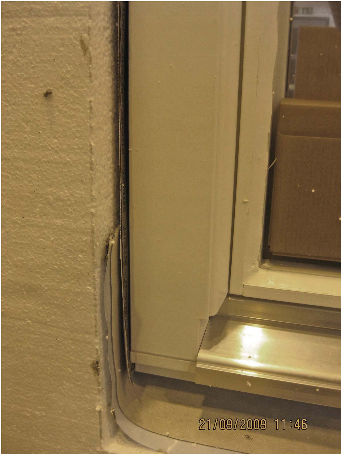
Bild 4: Utsida vägg. Folieband är klistrad på fönsterkarmens sidostycken och överstycke och ut på cellplast.
