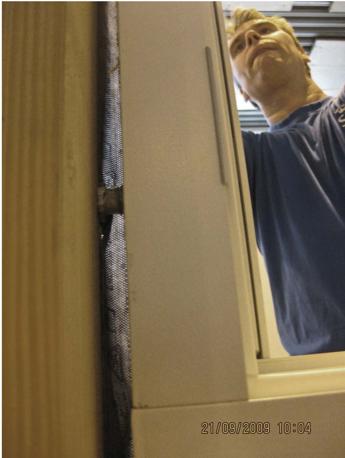
Bild 10: Insida vägg. Folieband klistrad på fönsterkarmens sidostycken och överstycke och ut på regelverket.
