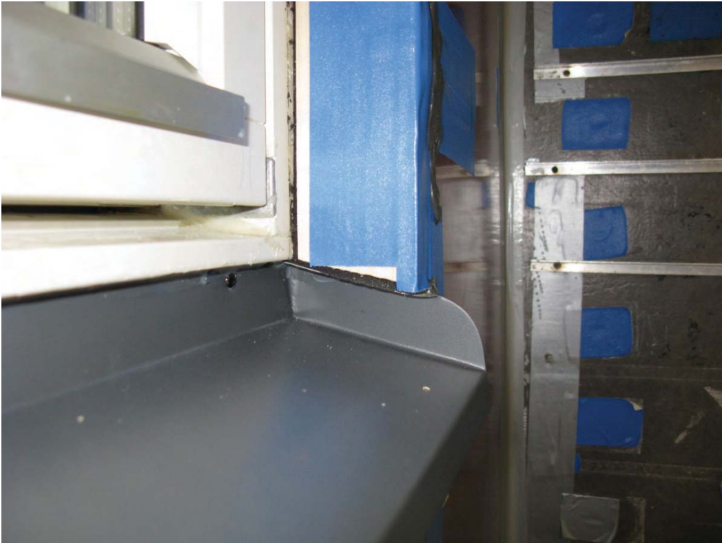
Bild 3: Fog mellan fönsterbleck, puts och fogband
