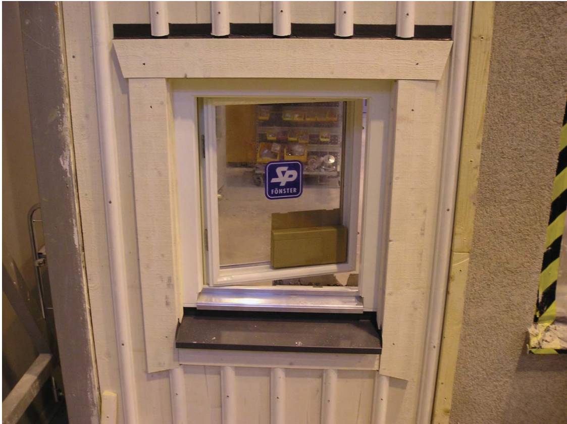
Bild 28: Utsida vägg. Slutligen skapades dränage och tryckutjämningsöppning på ca 8 mm mellan underkant fönsterbleck och underliggande foder (ej synligt på bild). Färdigt montage kan ses på bild.
