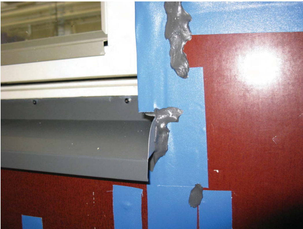
Bild 4: Knådplast som motsvara fog mellan puts och fogband vid sidan av fönsterbleck
