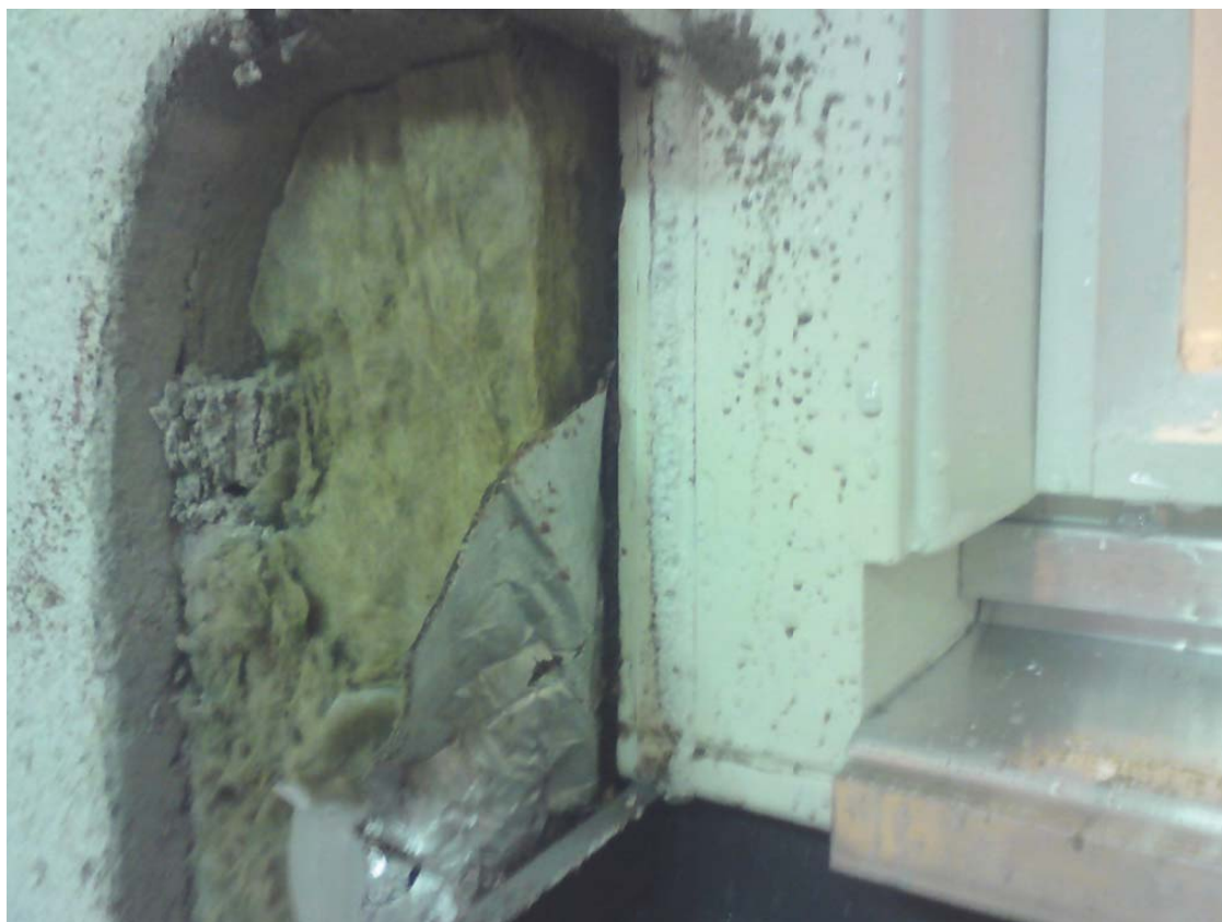
Bild 19.1: Utsida vägg. Tryckutjämningen har ej fungerat här pågrund av att Bitumenfolien är tilltryckt av stenullen
