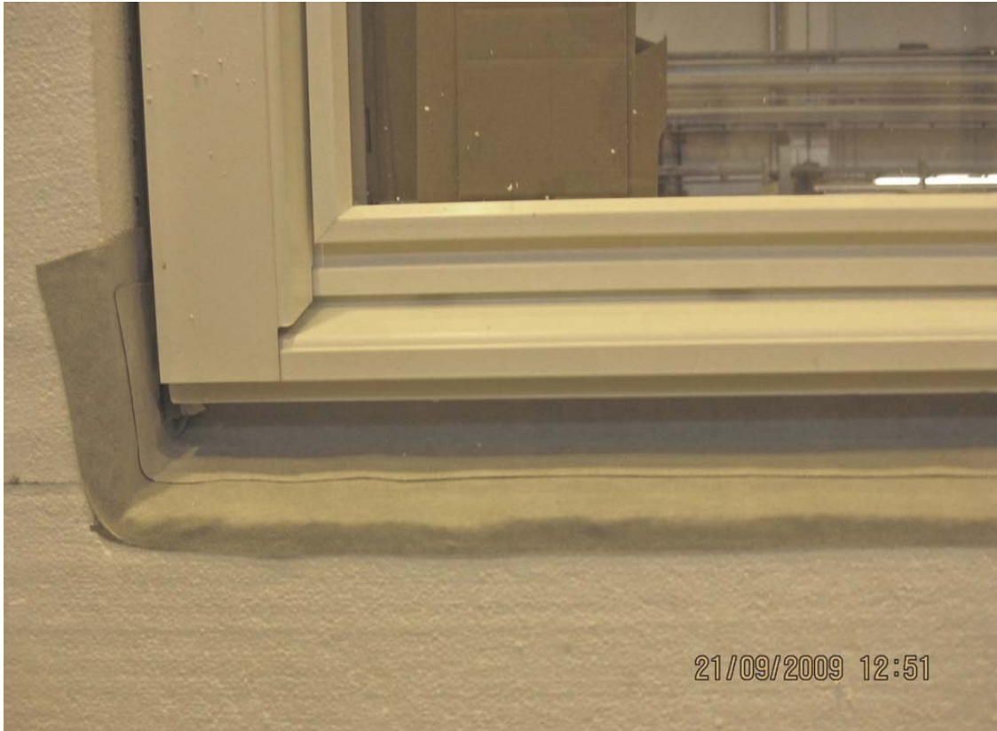
Bild 9: Utsida vägg. Fiberduk hela vägen ut till utsidan av cellplast samt uppvikt ca 10 cm på vertikal regel och cellplast.
