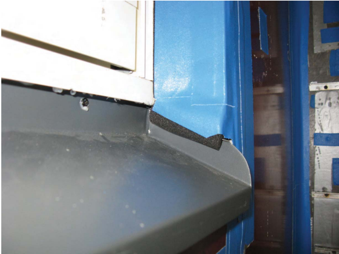
Bild 11: Fog mellan fönsterbleck, puts och fogband.
