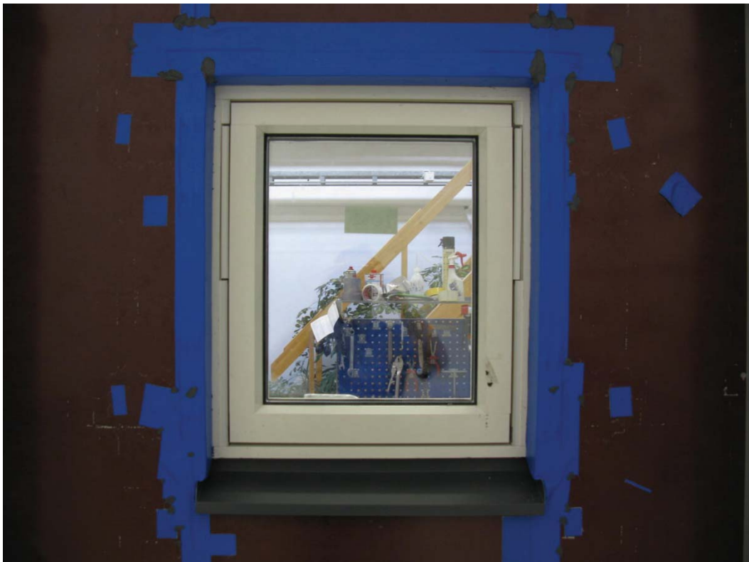
Bild 2: Utsida vägg. Färdigt montage.
