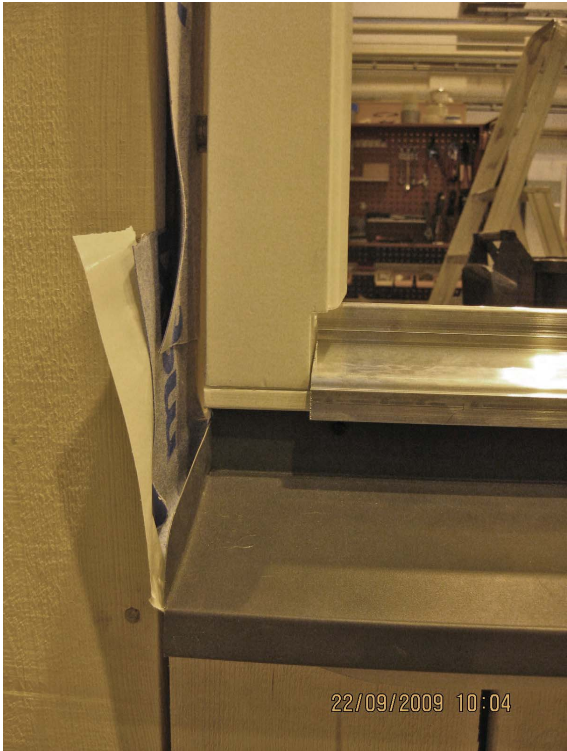
Bild 27: Utsida vägg. Fönsterbleck med 30 mm uppvik i bakkant och 14° lutning, monterat med silikon och skruv.
