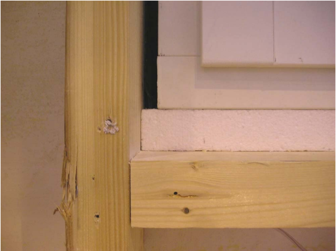
Bild 7: Insida vägg. Fönstret ovan givare 7-8 står på cellplast.
