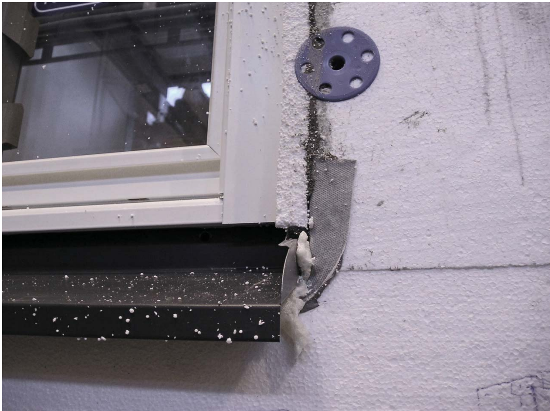
Bild 11: Fogband monterat under press av cellplastdetaljer.
