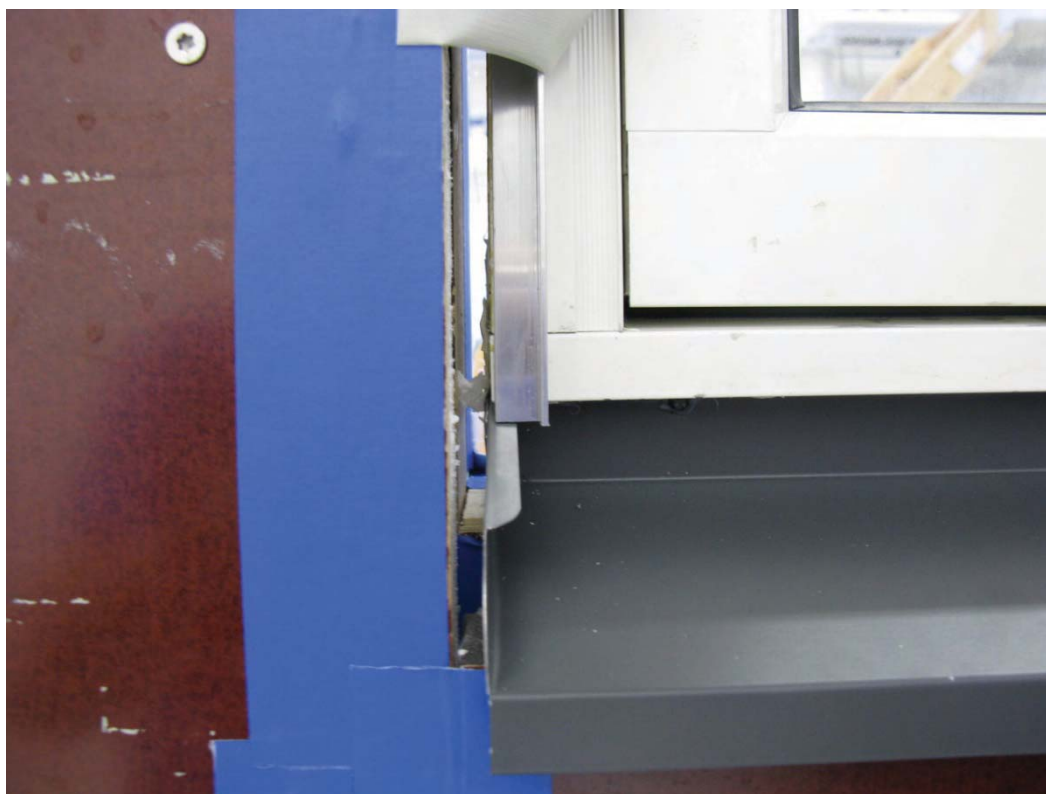
Bild 1: Montage av putsprofil
