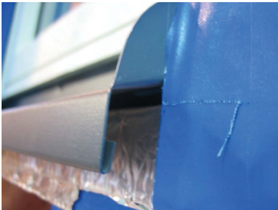
Bild 5: Utsida vägg. Här syns dränering/tryckutjämningsöppningen på ca 8 mm.
