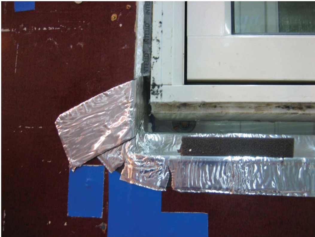
Bild 3: Utsida vägg. Detalj av Bitumenmatta, innan puts (blå tejp) applicerades.
