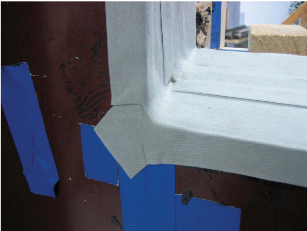
Bild 2: Illmod trio klistrad runt om hela fönstret.
