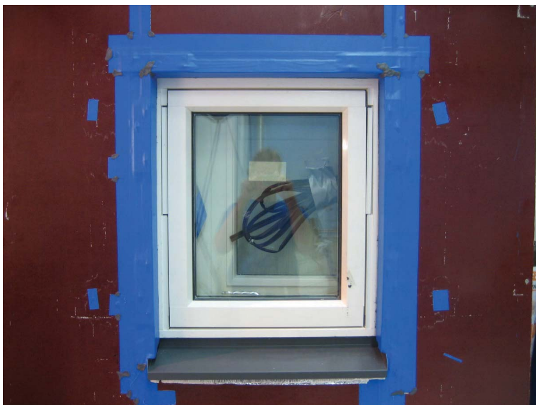
Bild 6: Utsida vägg. Färdigt montage.
