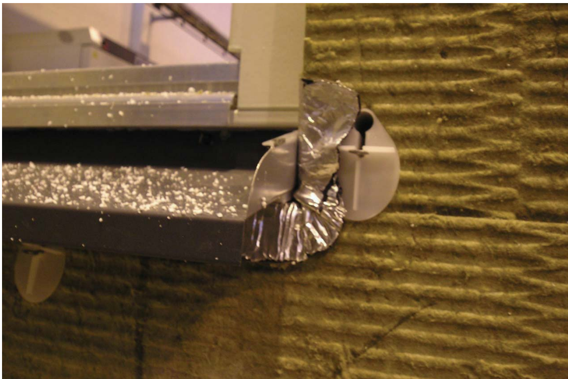
Bild 18: Utsida vägg. Fönsterbleck med 30 mm uppvik i bakkant och 14° lutning, monterat med silikon och skruv. Bitumenfolien "baljan" är klistrad från upplaget av fönstret och vikt ut på stenullen i ett stycke.
