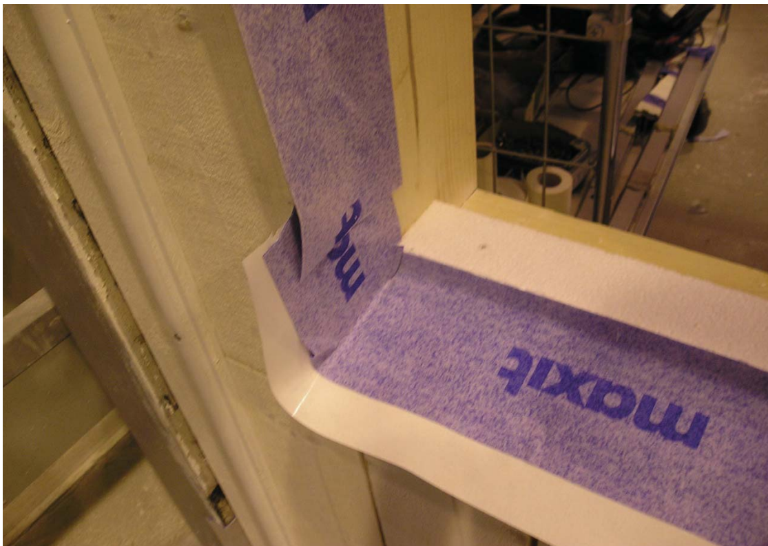
Bild 25: Utsida vägg. Fönstret vilar på en rektangulär cellplast som motsvarar ca halva karmens djup. Fiberduken "baljan" är klistrad på fronten av cellplasten och vidare ut på en träkil som är sågad i 14° lutning, och som har mättet (10 mm i bakkant) och ned till intet, och hela vägen ut till utsidan av cellplast samt uppvikt ca 10 cm på vertikal regel.
