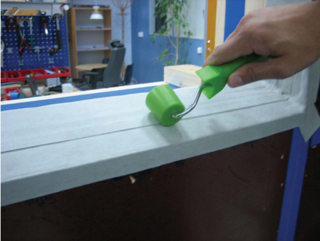
Bild 1: Illmod trio klistrad runt om hela fönstret.
