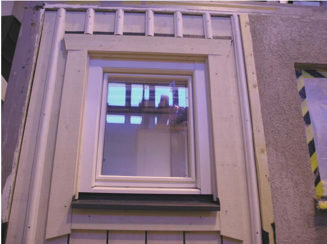
Bild 32: Utsida vägg. Slutligen skapades dränage och tryckutjämningsöppning på ca 8 mm mellan underkant fönsterbleck och underliggande foder ( ej synligt på bild). Färdigt montage kan ses på bild.
