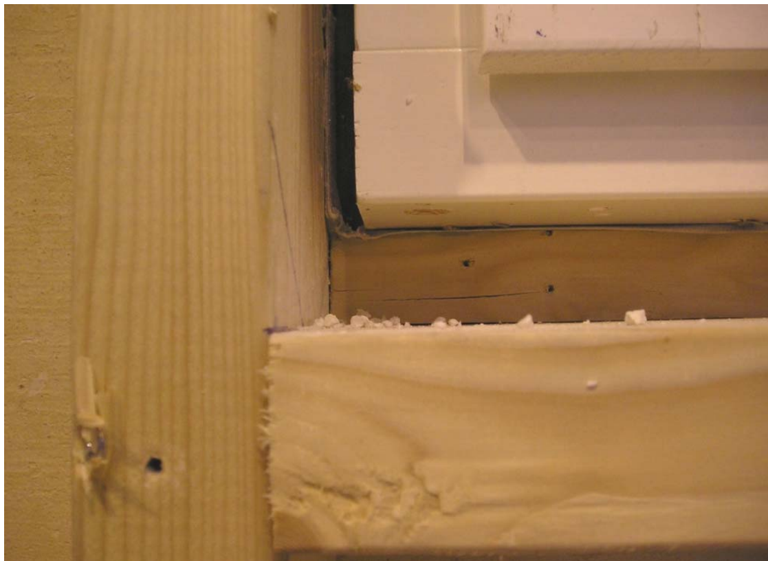
Bild 2: Insida vägg. Fönstret ovan givare 1-2 klämmer duken mot träkilen som är sågad i 25° lutning. Fiberduken är klistrad på träkil med djup som motsvarar ca halva karmens djup.
