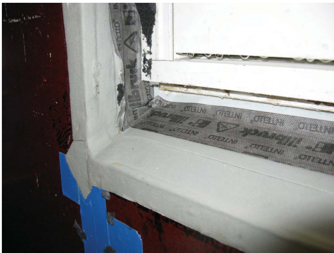
Bild 13: Utsida vägg efter provning med fönsterbleck borttagen
