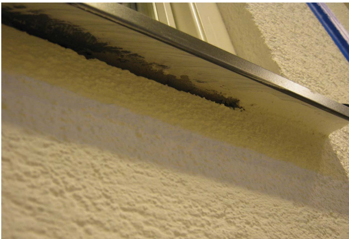
Bild 19: Utsida vägg. Slutligen skapades en dränage och tryckutjämningsöppning under fönsterblecket.
