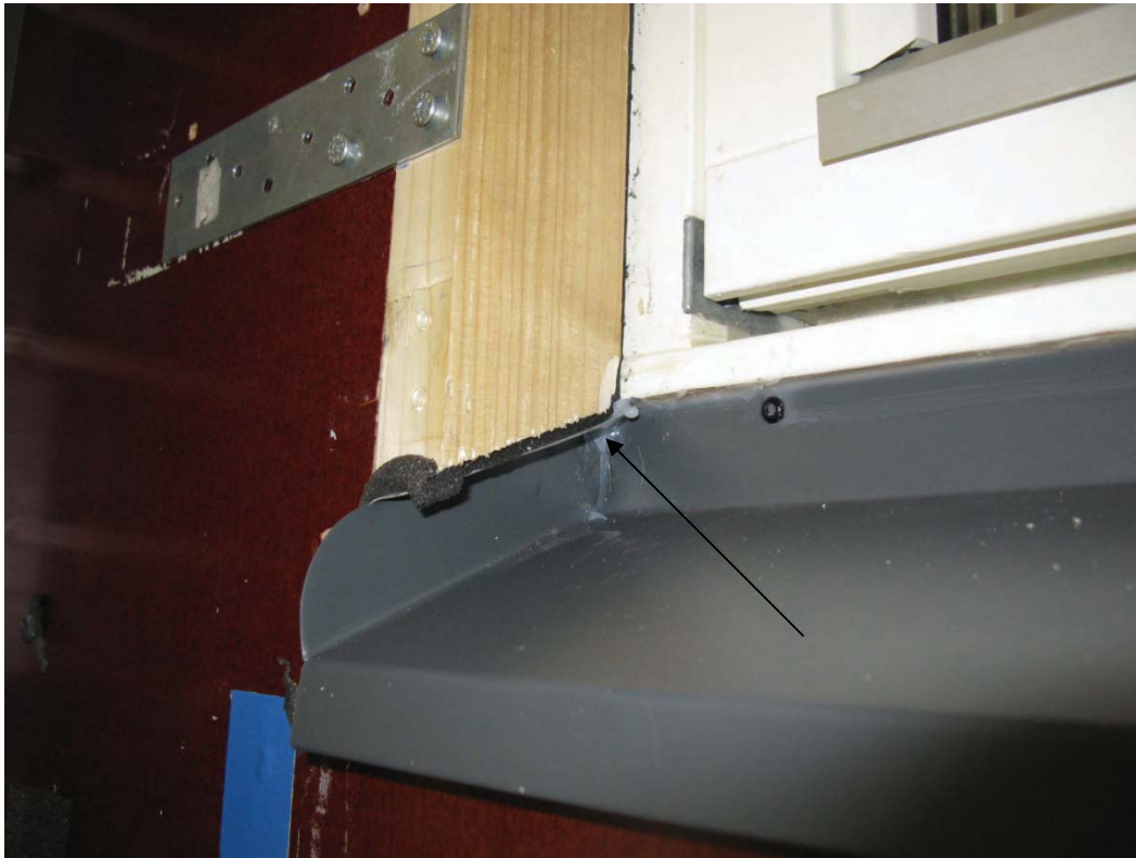
Bild 1: Fogband monterat under press från anpassade träreglar. Silikon applicerades i hörnet av fönsterbleck
