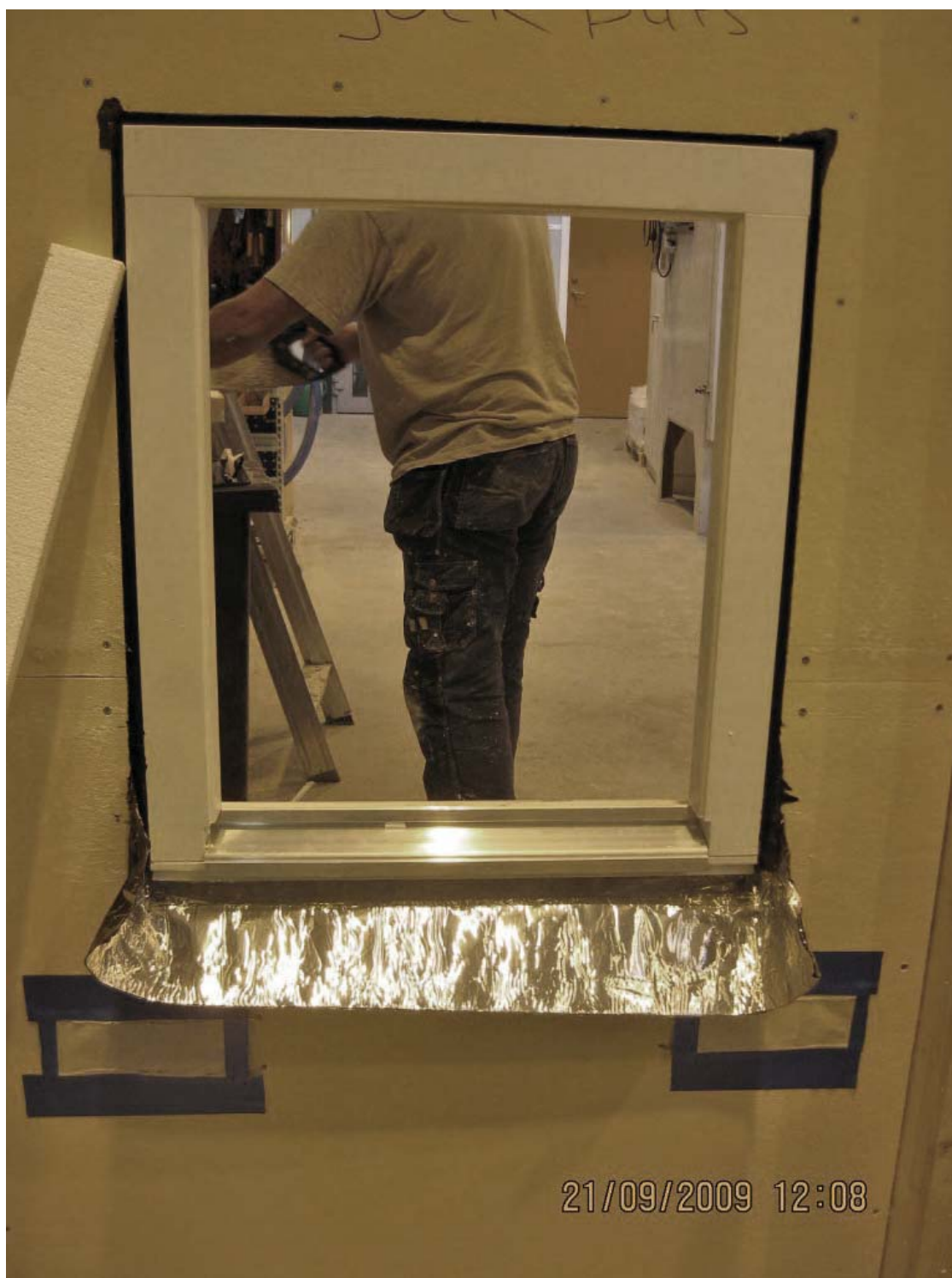
Bild 17: Utsida vägg. Butyl klistrad på fönsterkarmens sidostycken och överstycke och ut på regelverket i formen av ett "u".
