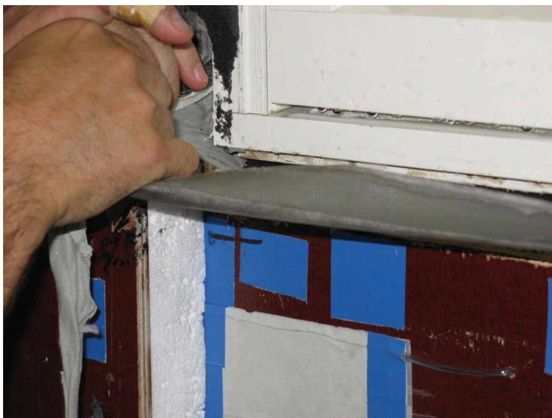
Bild 16: Torr fuktgivare under fönstret
