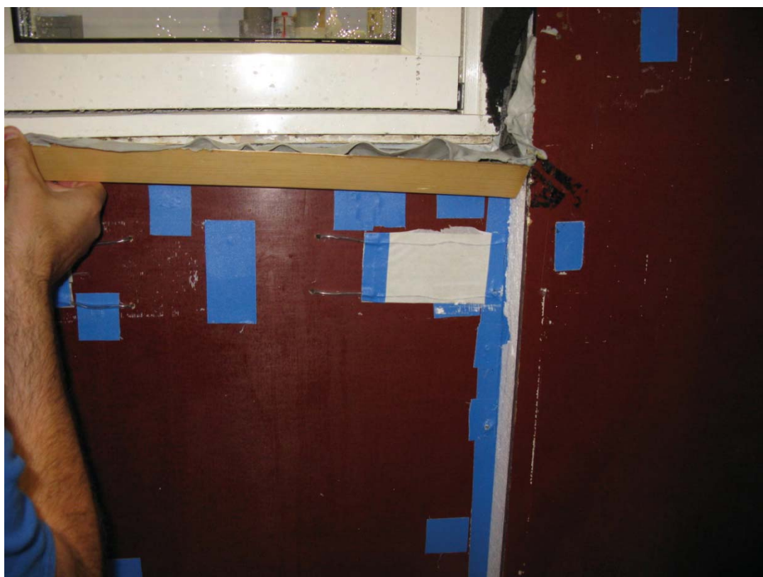
Bild 14: Demontering av kilbrädan under fönstret
