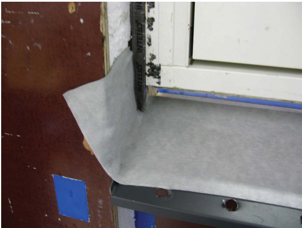
Bild 5: Utsida vägg. Läckaget i vänstra nedre hörnet droppar ner på fiberduk, som i sin tur för detta till dränagehål i fästbleck och till utsida puts.
