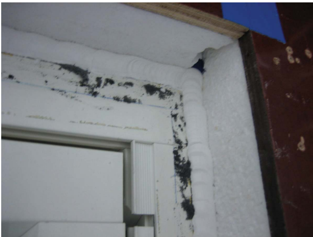
Bild 5: Utsida vägg. Fog applicerad.
