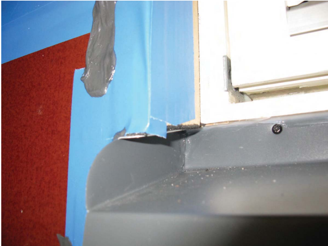
Bild 3: Utsida vägg. Detalj av färdigt montage.
