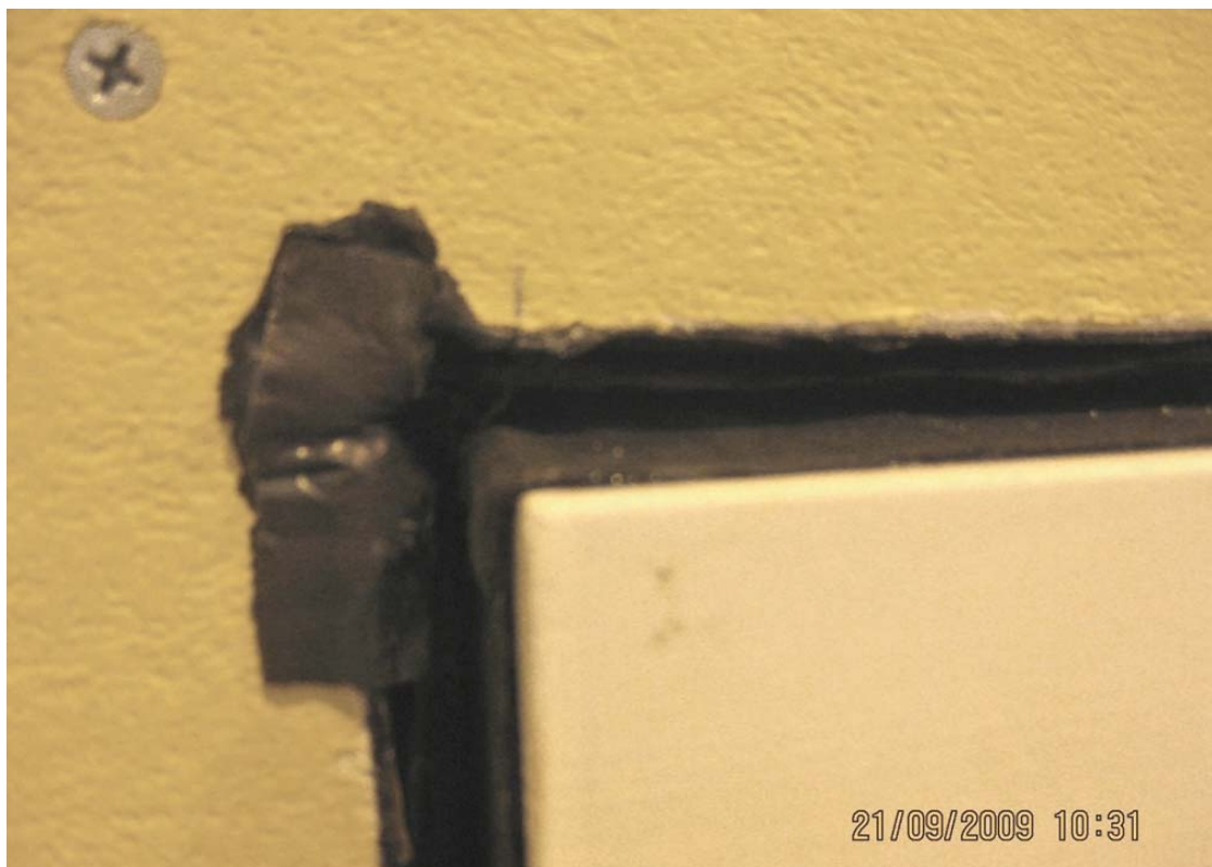
Bild 30: Utsida vägg. Bitumenband klistrad på fönsterkarmens sidostycken och överstycke och ut på regelverket i formen av ett "u". Obs! denna bild visar montage av fönster med "tjockputs", men principen var det samma vid detta montage.
