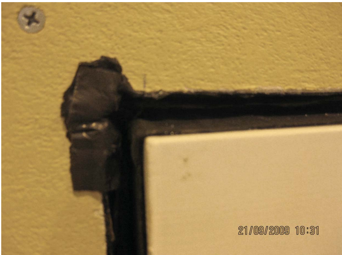
Bild 16: Utsida vägg. Butyl klistrad på fönsterkarmens sidostycken och överstycke och ut på regelverket i formen av ett "u".
